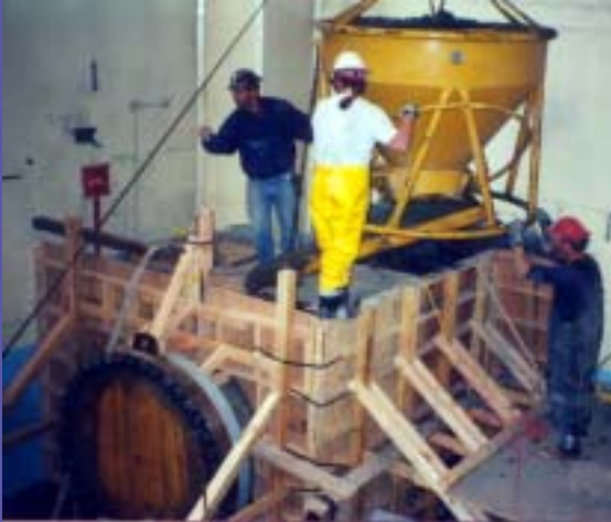
Pouring Thrust Block
